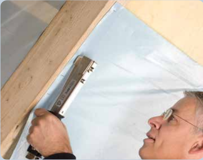
Rápida fijación de láminas.
