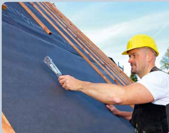
Fixation rapide et facile des films sur un toit.
