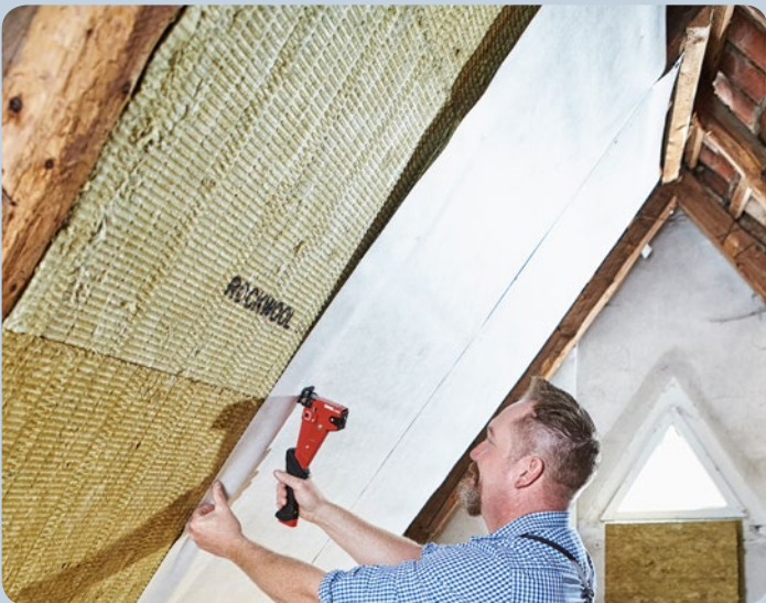
Folie beim Dachbodenausbau einfach befestigen.
