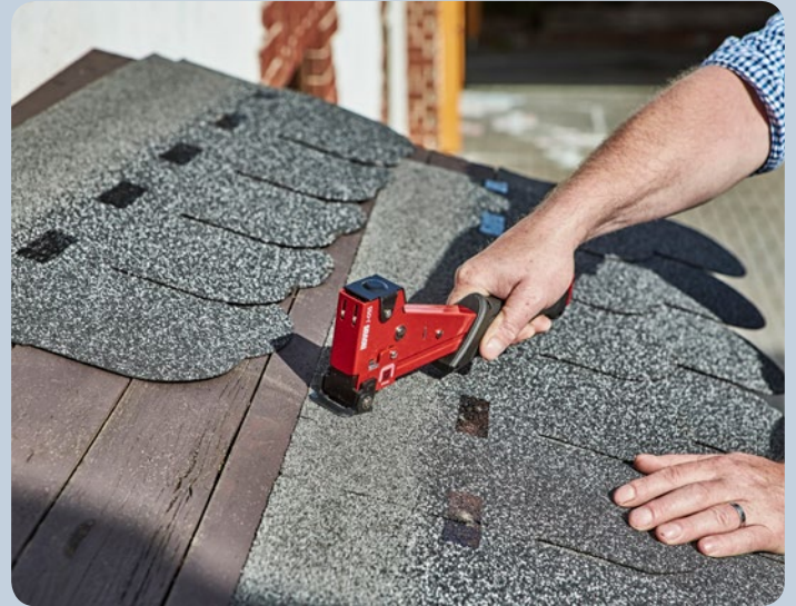
Schnelles Befestigen von Bitumenschindeln.
