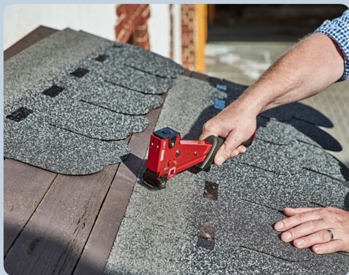
Fijación rápida para tejas de fibrobitumen.
