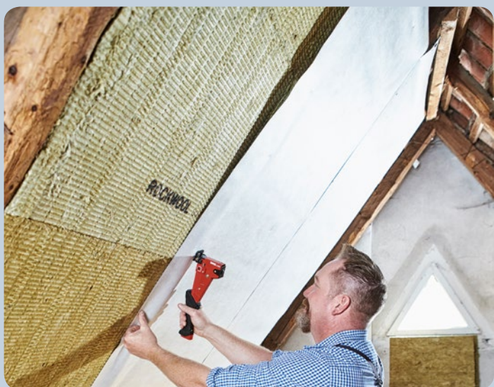
Fijación sencilla de láminas en trabajos de ampliación de áticos.
