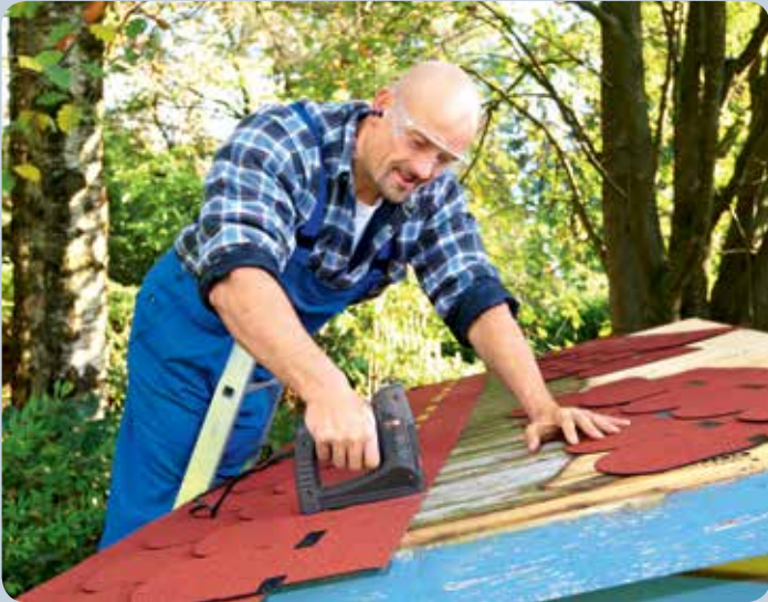
Fixation rapide des bardeaux en bitume.
