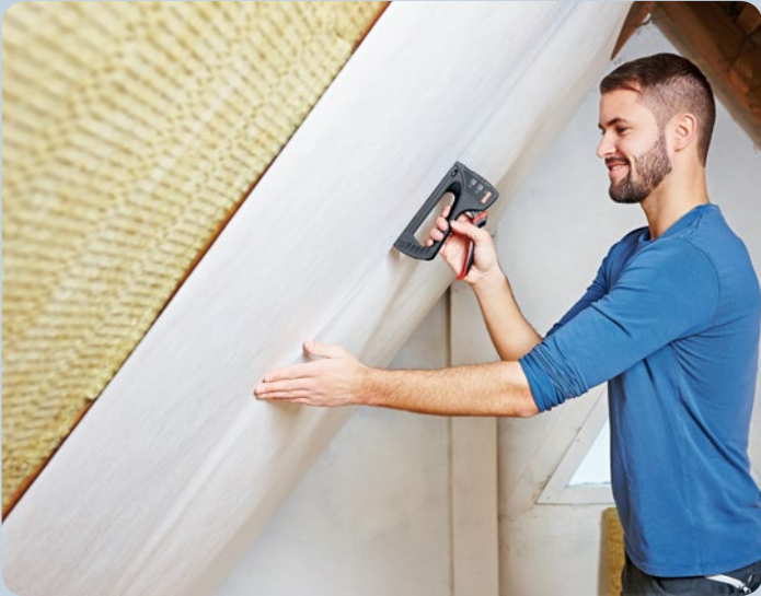
Folie beim Dachbodenausbau einfach befestigen.
