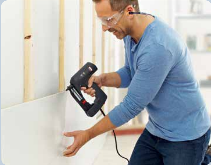
Direktes Befestigen von Profilhölzern.
