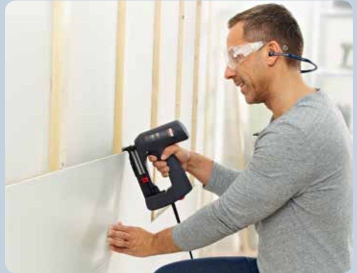
Profilhölzer mit Profilholzkrallen befestigen.
