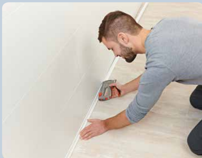
Il est possible d'agrafer facilement et rapidement les baguettes.
