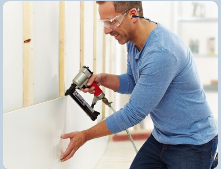
Direktes Befestigen von Profilhölzern.
