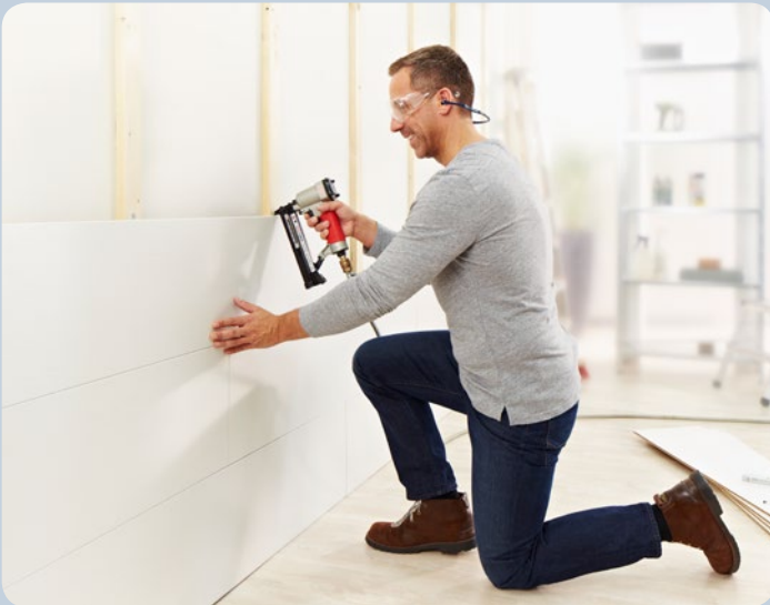
Profielhout met profielhoutkrammen bevestigen.
