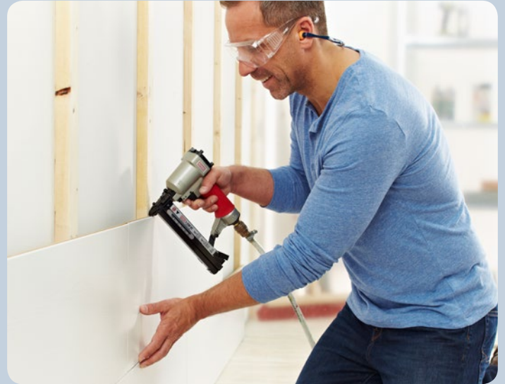
Direct bevestigen van profielhout.
